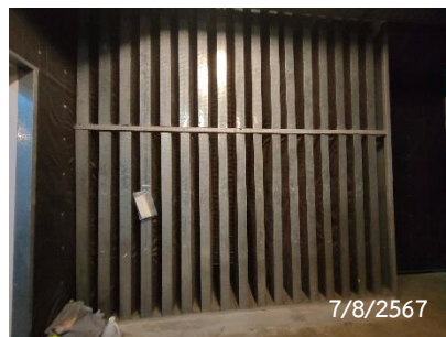
ตะแกรงกันเสียงที่บริเวณหน้า Gravity Shutter
