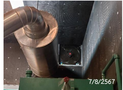
ระบบท่อไอเสียจากห้องเครื่องกำเนิดไฟฟ้า
