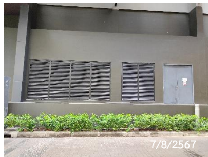
ช่องระบายไอเสียจากห้องเครื่องกำเนิดไฟฟ้า
